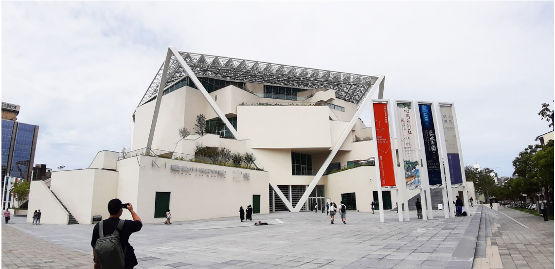
▲ 南美館二館於友愛街與忠義路二段交叉處入口，一旁豎立當期特展介紹。
