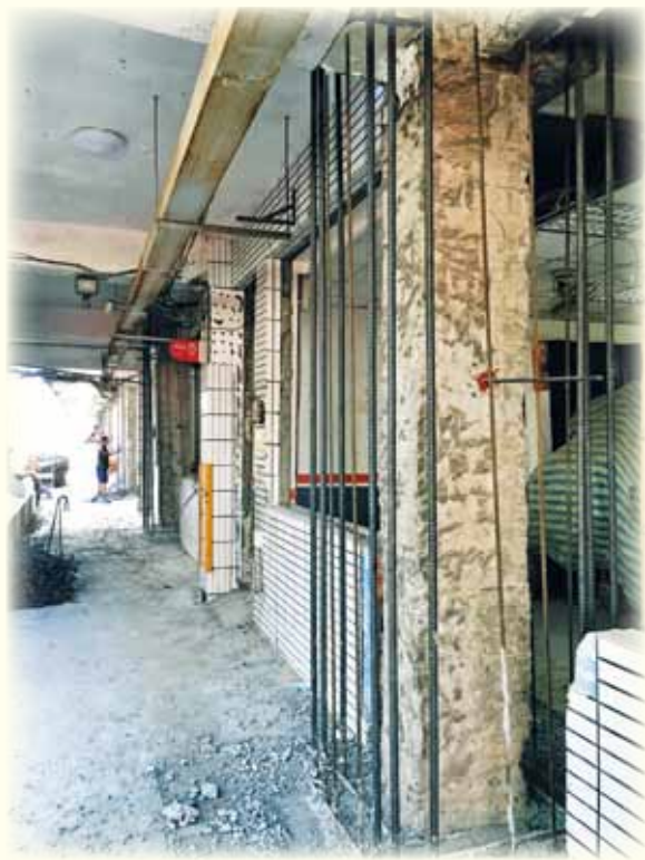
建築安全也是校園安全的一部分，於暑假期間進行擴柱工程，補強校舍結構。
