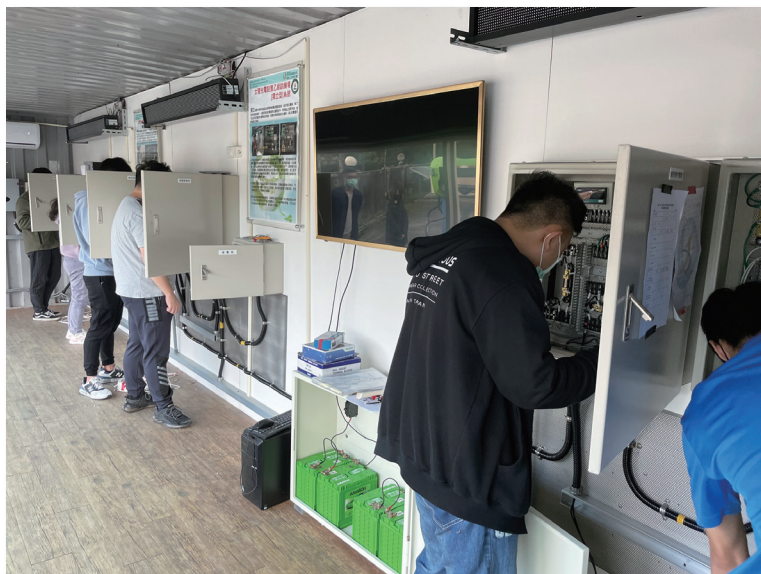
圖 1 東臺灣太陽光電系統設置與維運技訓班之技訓過程
