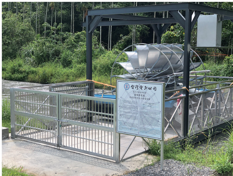
圖 2 參與社區微水力發電籌劃與建置
